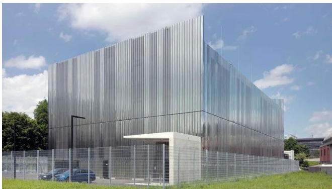
NorthC Datacenter à Bienne
